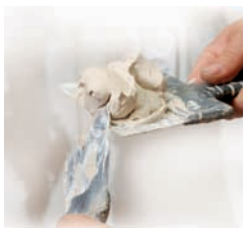
Produkcja cementu i zapraw murarskich
